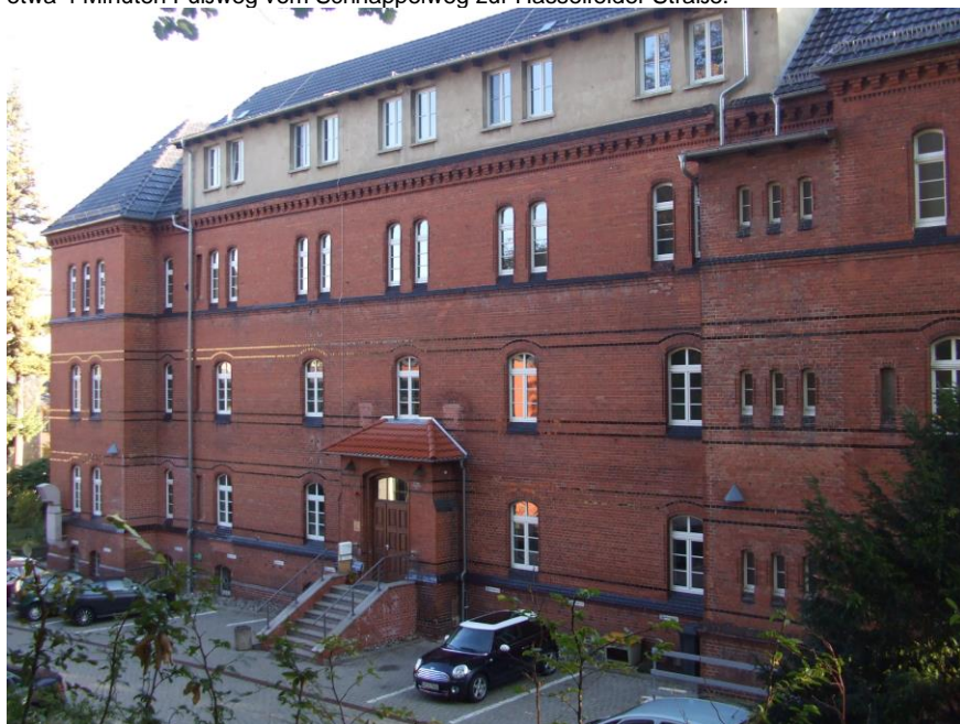
AFI LSA Standort Blankenburg (Hauptgebäude)
