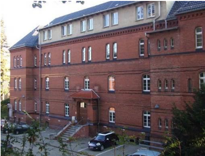
AFI-LSA Standort Blankenburg (Hauptgebäude)
