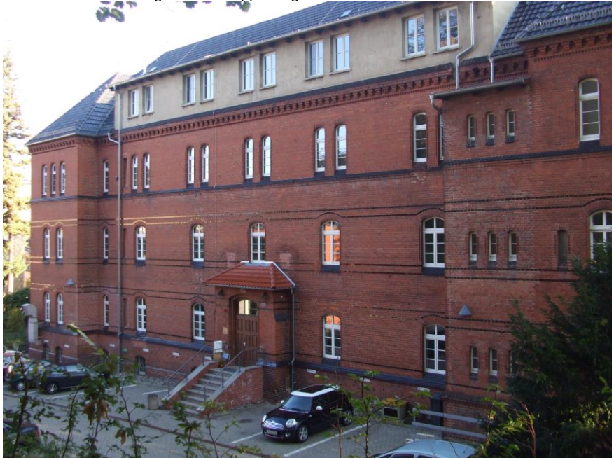
AFI LSA Standort Blankenburg (Hauptgebäude)
